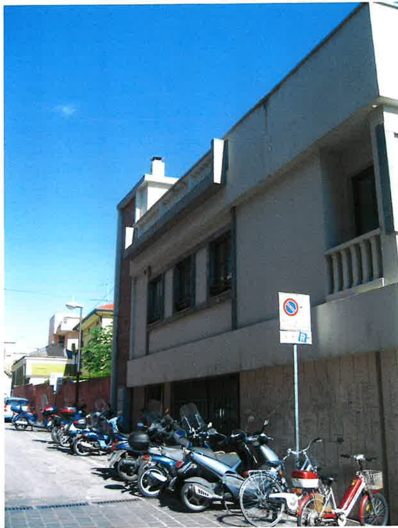
Immobilie BANCA DELLE MARCHE da Via Fiume - punto di ripresa "C"
