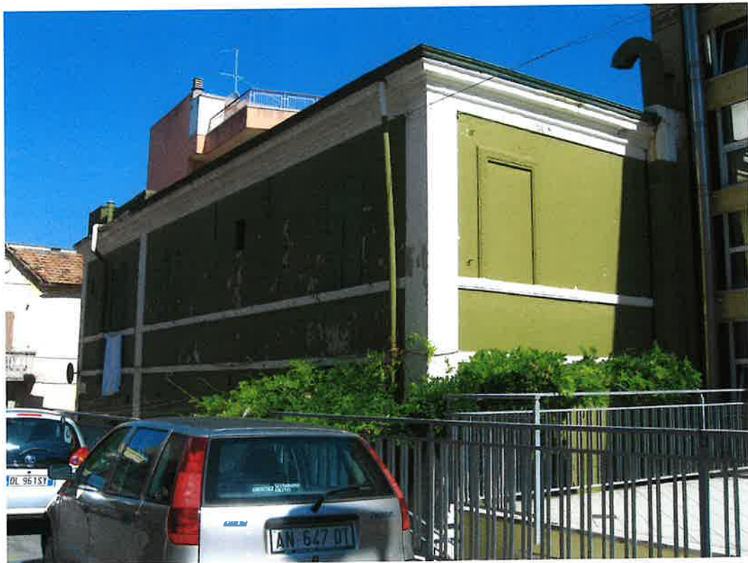
Immobilie C (proprietà Scola Carlo e Ridolfi Paola) da Via Fiume - punto di ripresa "F"
