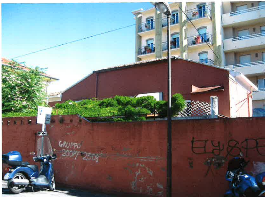
Immobilie B ( proprietà Cola Silvana) da Via Fiume - punto di ripresa "D"
